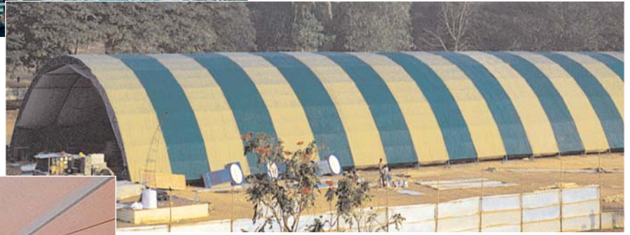
150 meter long hanger.
